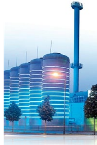
5 Wärmespeicher mit jeweils 400 m 3 Fassungsvermögen
