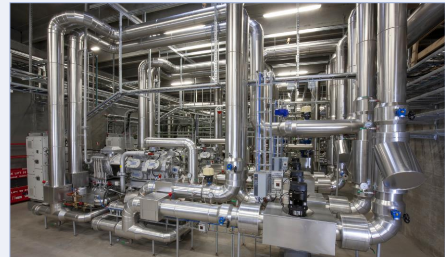
Beispiel einer Wärmepumpe, © Johnson Control
