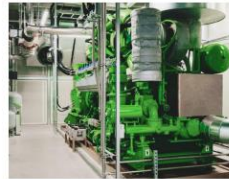
Der Jenbacher Gasmotor nutzt regionales Biogas zur Strom- und Wärmeproduktion.
